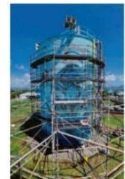
Le gigantesque échafaudage et le croquis de l'œuvre déjà entrevoir l'ampleur de la tâche.
